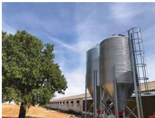
Foto 2. Exterior de la nave, desde su cabecera, con las trampillas para la entrada de aire y sus 2 silos.
