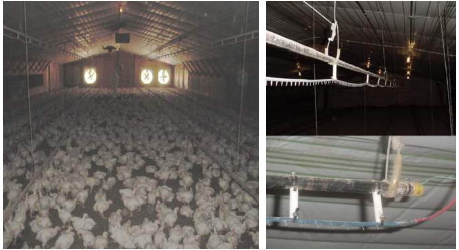
FIGURA 3. Control del polvo en naves de pollos (Ritz y col., 2006)
