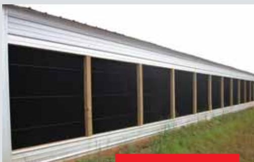
Entradas de aire de una nave de tipo túnel.
