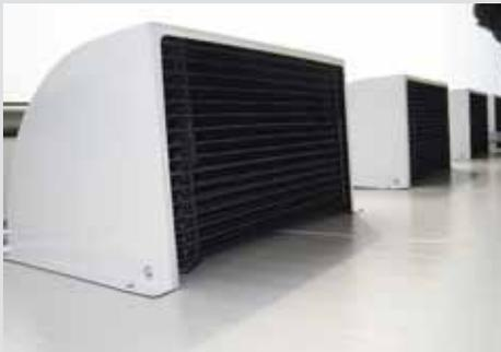
Las trampillas de entrada perimetrales se instalan en cajones exteriores a prueba de viento. El área transversal de los mismos debe ser, al menos, un 30 % mayor que la de la propia entrada perimetral. Las trampillas de luz tienen un tamaño similar para adaptarse a la abertura del cajón.
