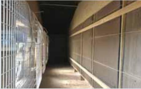
Una opción para una instalación eficiente de las trampillas en una nave con ventilación túnel es construir una pared falsa que incorpore las trampillas de luz, situadas a 1,5 m del extremo de los ventiladores. Esto permite que el aire pase a través de todas las trampillas de luz, reduciendo la caída de presión cuando la nave no funciona en modo túnel completo.
