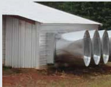
Falsa entrada de luz instalada en un vestíbulo plenum frente a los ventiladores del túnel montados en los lados de la nave.
