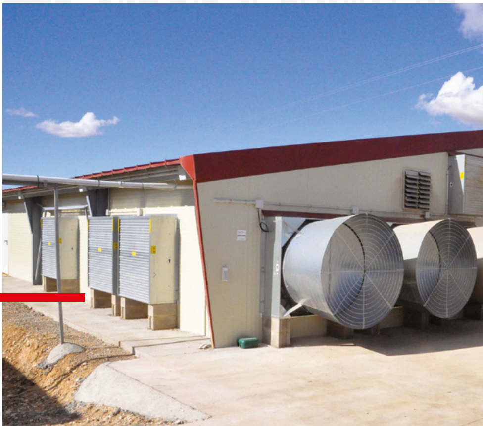
10 El extremo “sucio” de una de las naves, con el gran portón para retirada de los pollos y la colocación de los distintos ventiladores.
