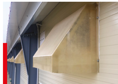
11 La abertura de ventilación desde fuera de la nave. Al ser translúcida permite la entrada plena de luz exterior a la nave.
