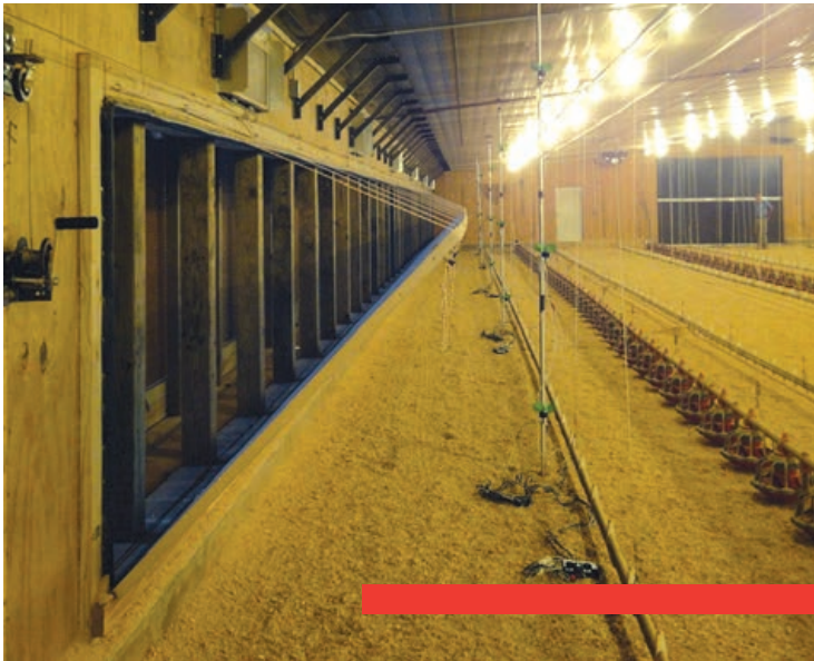
FIGURA 8. Compuerta del túnel abierta a un ángulo de 45°.
