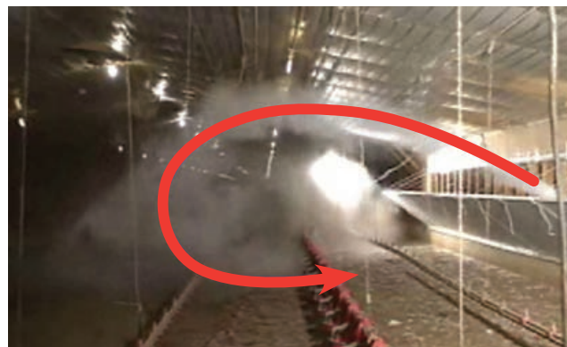
FIGURA 2. Patrón circular de flujo de aire creado por compuertas de túnel.
