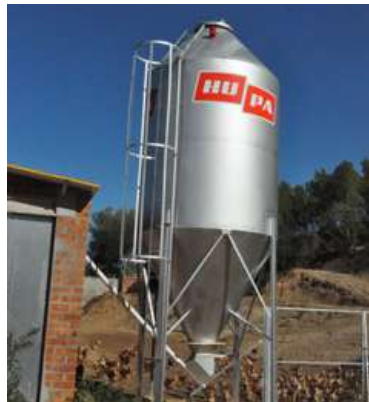
El silo de la misma nave, con el detector de su contenido, por radar.
