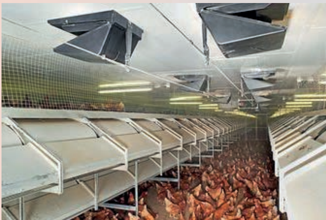
Entradas de aire fresco por el techo, a través de un cielorraso.
