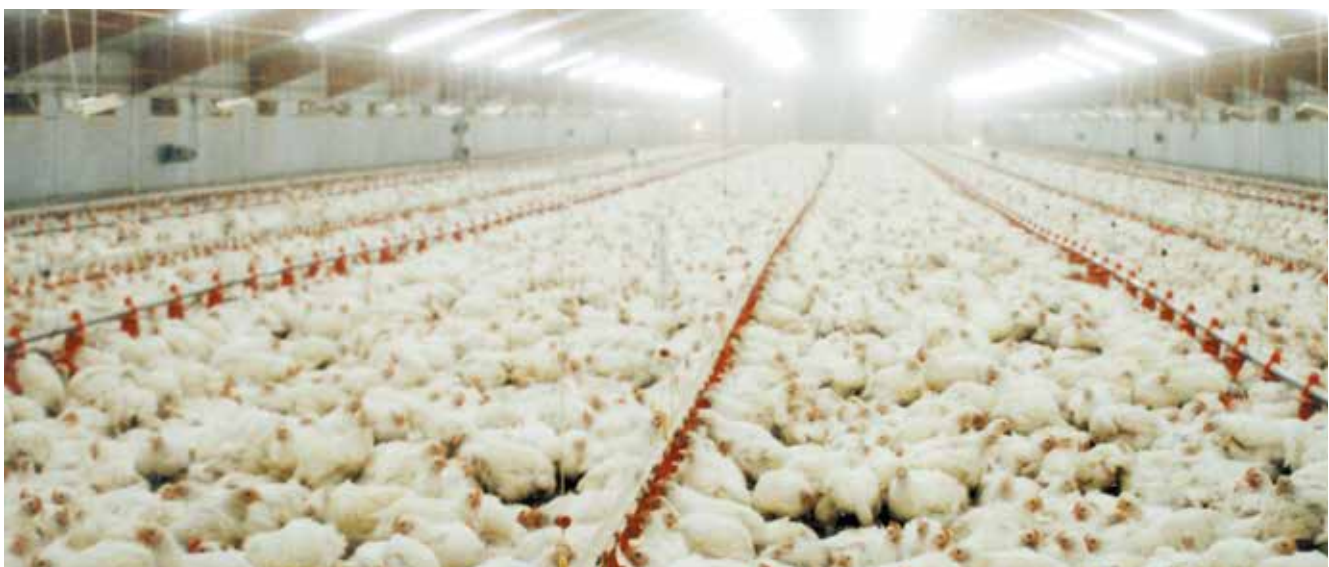
► Una clásica instalación con tubos fluorescentes, aparentemente con mucha más iluminación de la necesaria.
