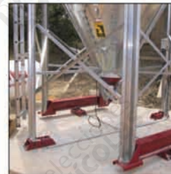
Silos con células de carga
