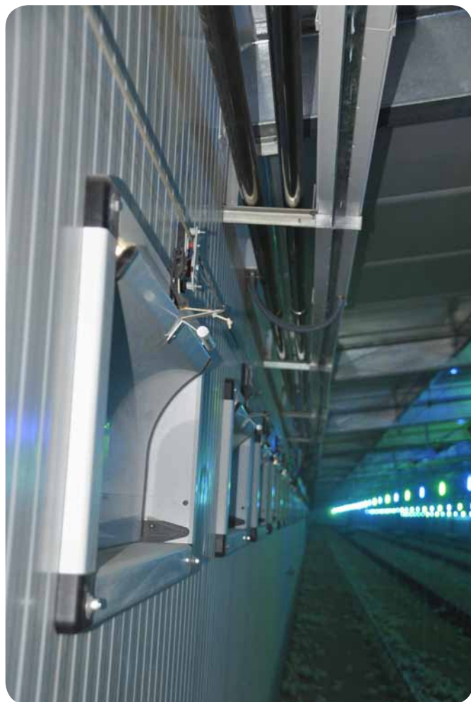
Detalle de las entradas de aire.
