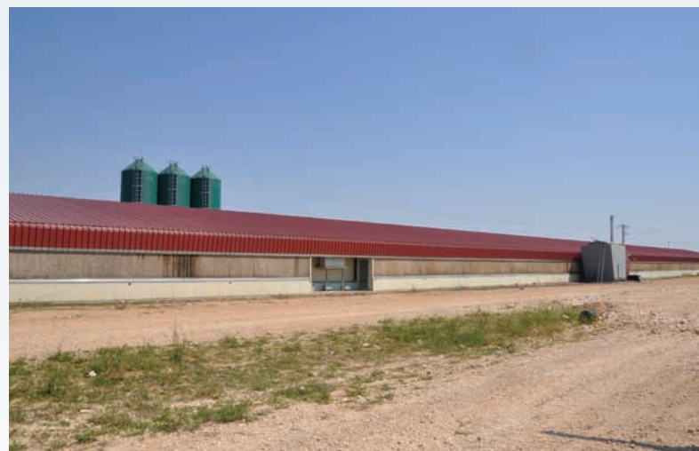
Nave con ventilación transversal. Podemos ver paneles de refrigeración a lo largo de todo el lateral.
