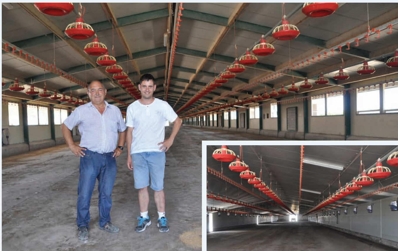
Nave con ventanas y ventilación transversal construida hace siete años. Luis y David Salas, los propietarios.
