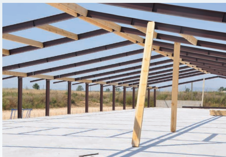
Detalle de las correas de madera y de las vigas.
