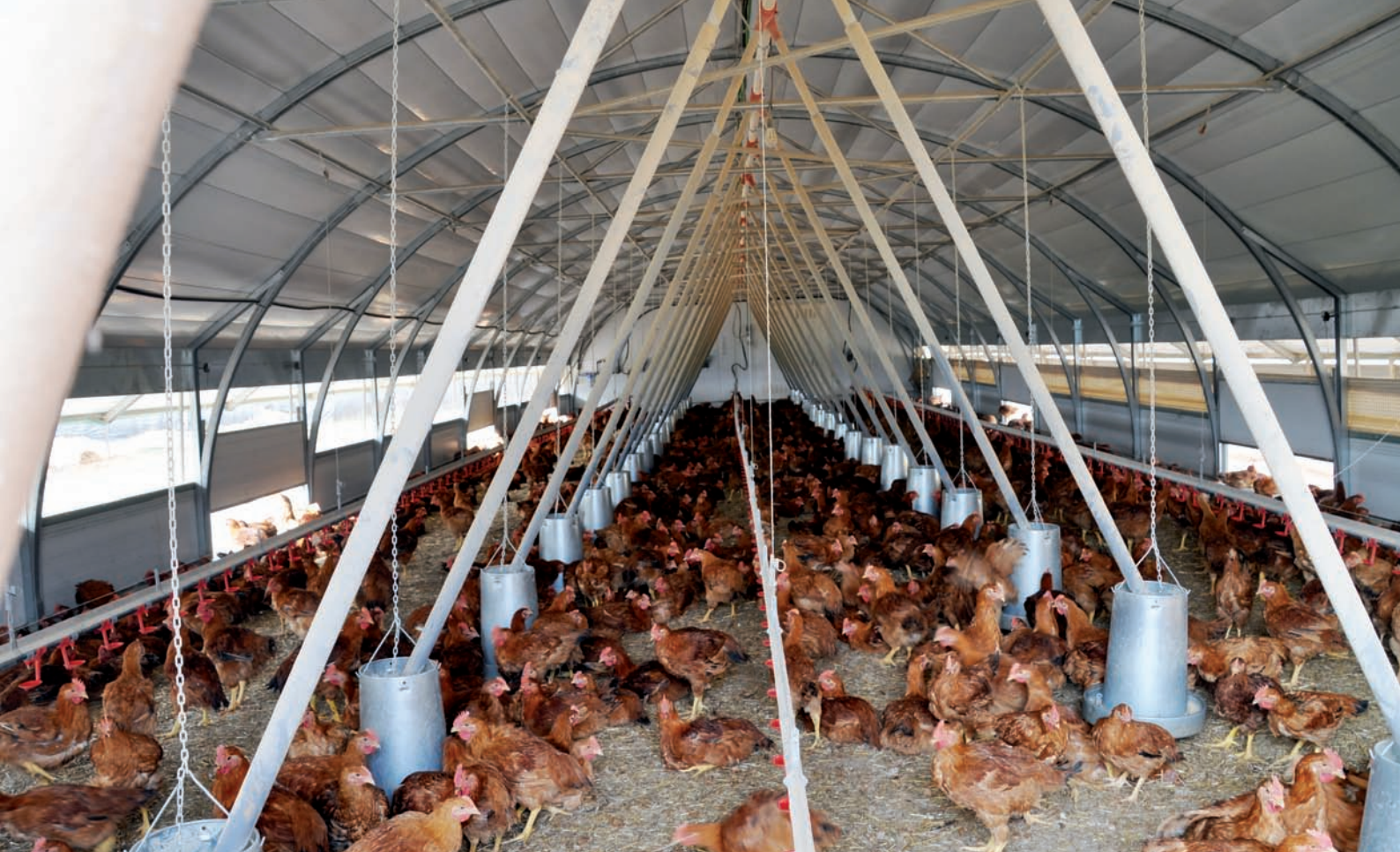
Vista interior de una de las naves donde se observa el refuerzo interior de la estructura.
