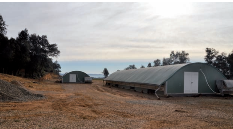
Vista general de la granja.
