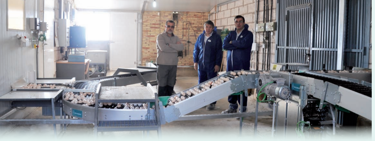
Punto de encuentro de los tres tramos de cinta.
