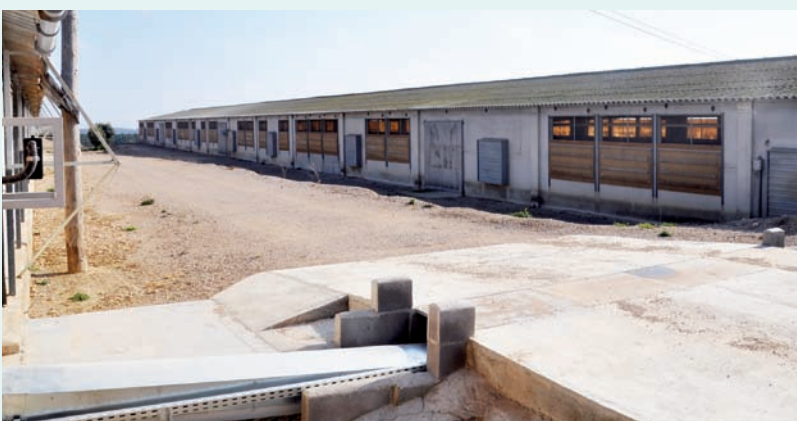
Diferentes tramos de Vencobelt desde las tres naves al centro de recogida.
