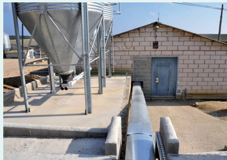
Diferentes tramos de Vencobelt desde las tres naves al centro de recogida.
