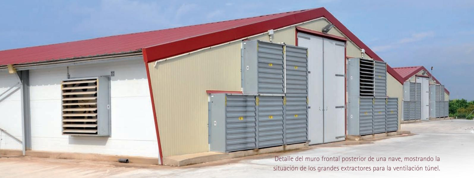
Detalle del muro frontal posterior de una nave, mostrando la situación de los grandes extractores para la ventilación túnel.
