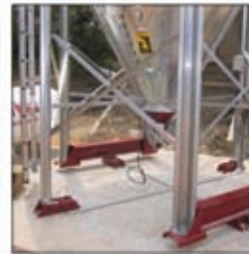
Silos con células de carga
