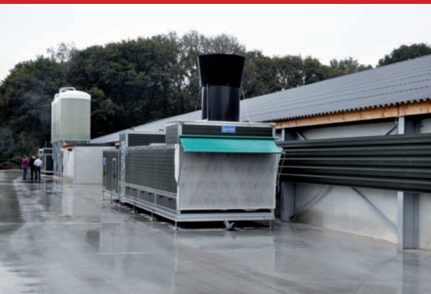
Ejemplos de intercambiadores de gran tamaño: el intercambiador de Exafan y el Clima+ de Vencomatic.
