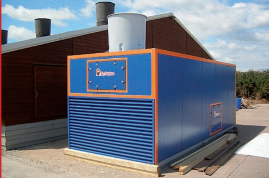
Otro ejemplo de intercambiador de gran tamaño. El Earny de Big Dutchman.
