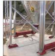
Silos con células de carga
