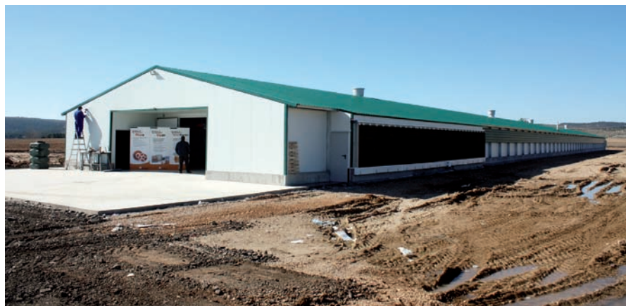
Vista exterior de la nave recién inaugurada, con el terreno ya preparado para la edificación de otra igual.
