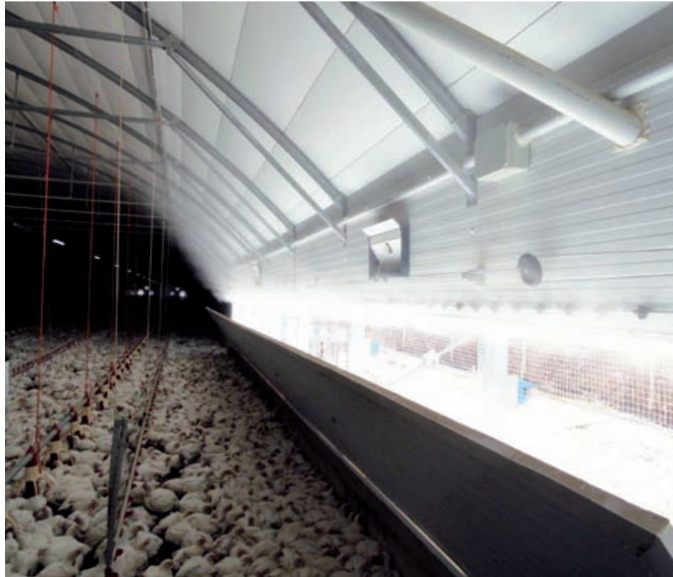
El panel de ventilación, ya abierto y con la vista de las boquillas nebulizadoras sobre él.
