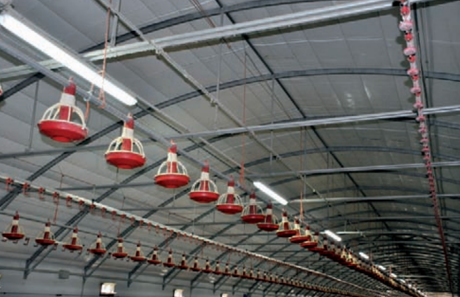
La estructura de la cubierta, en evidencia.
