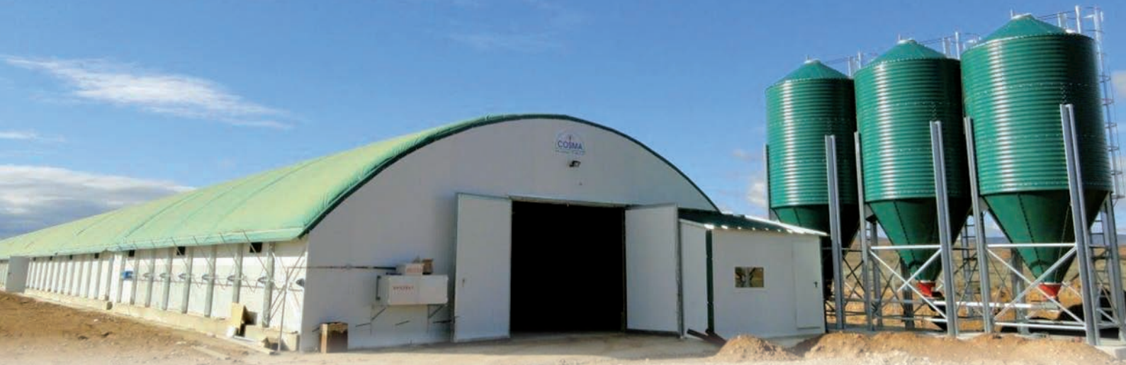
La entrada en la nave, con los silos y el almacén técnico en primer término.
