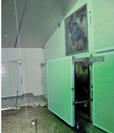
Interior del muro piñón por el que se realiza, cuando interesa, la ventilación túnel. Una de las compuertas de los grandes ventiladores solo se ha abierto para demostración.
