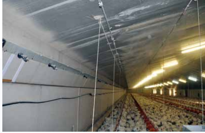
Los nebulizadores de alta presión, en marcha. Observar la trampilla corrida para entrada de aire.
