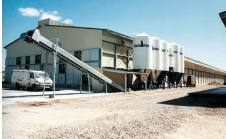
Unas de las naves de la granja de puesta, objeto de un reportaje el año pasado, ahora equipada con placas fotovoltaicas.
