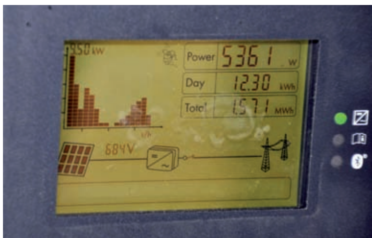
El cuadro indicativo de la situación de la carga de los paneles y su destino, el tiempo real y acumulado.
