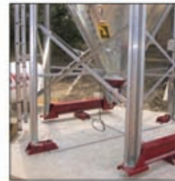
Silos con células de carga
