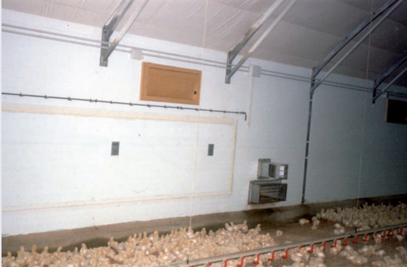
Detalle de una trampilla de ventilación, casi cerrada, una entrada de calefacción y un panel extra de ventilación de verano, cerrado.
