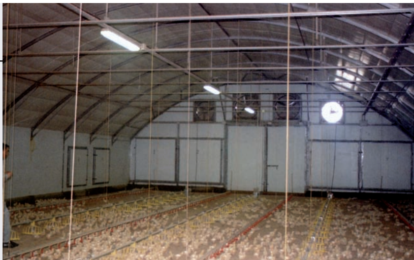
El mismo testero, con un ventilador funcionando, pero pudiendo verse las persianas y trampillas de los otros, parados.
