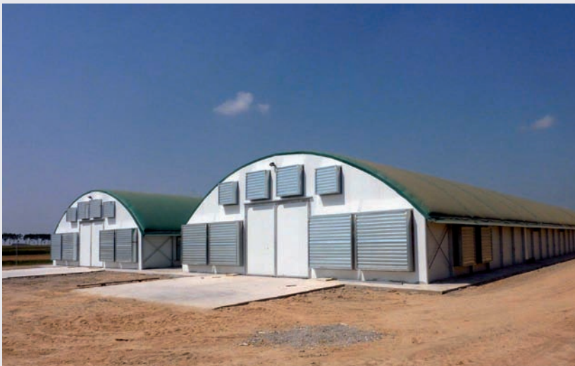
El muro testero por el que se realiza la extracción de aire.
