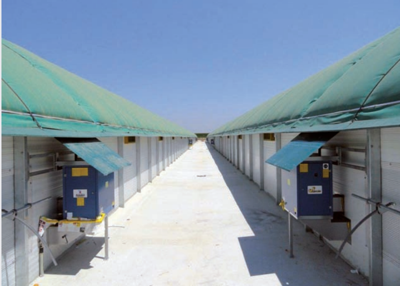
El pasillo entre las dos naves,, con el detalle de los calefactores.
