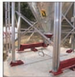
Silos con células de carga
