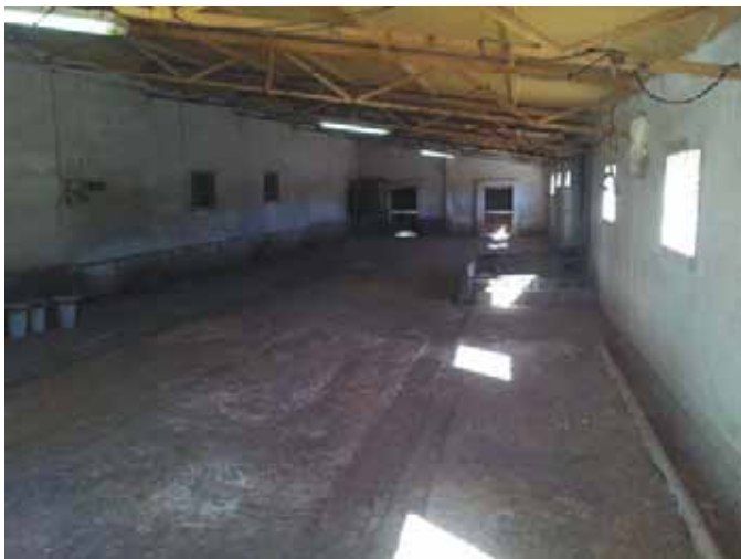
Nave de recepción de los pollitos.
