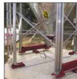
Silos con células de carga
