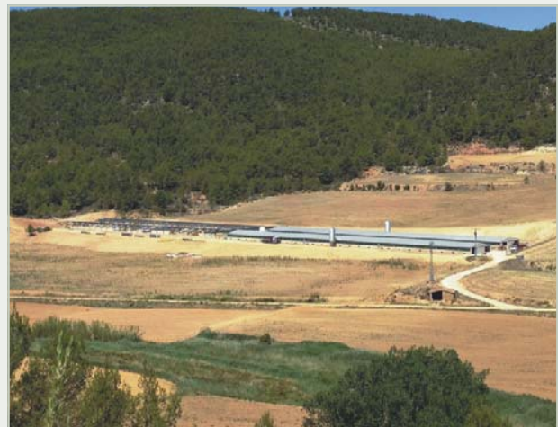
La nueva granja, en proceso de construcción.
