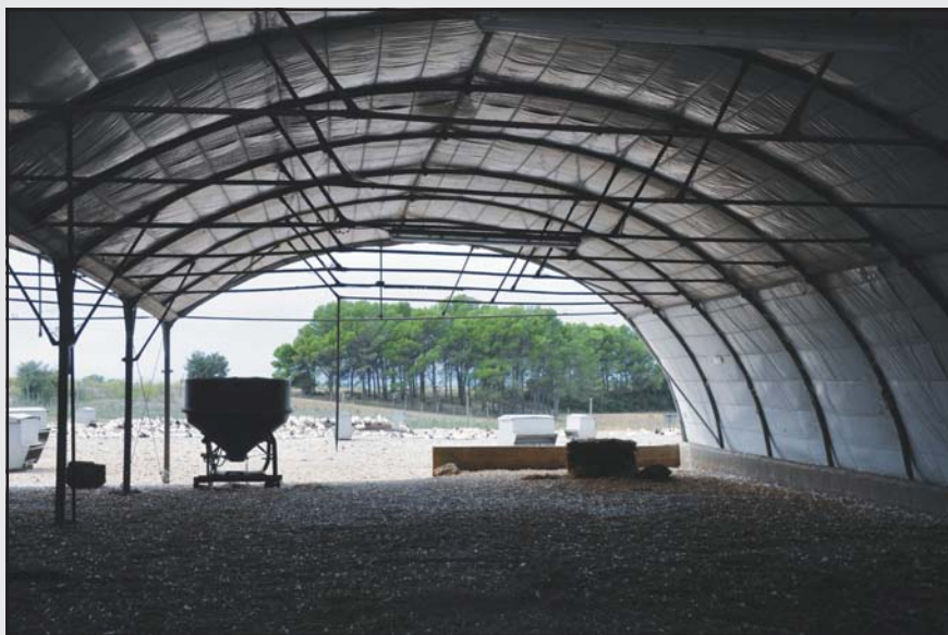
En esta etapa los patos pueden resguardarse, en caso de fuerte viento, en cobertizos aislados con fibra de vidrio.
