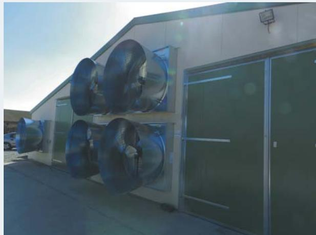
El extremo de una nave, con las turbinas para ventilación túnel.
