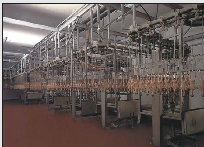
Sala de evisceración de las canales, en un matadero de URGASA.
