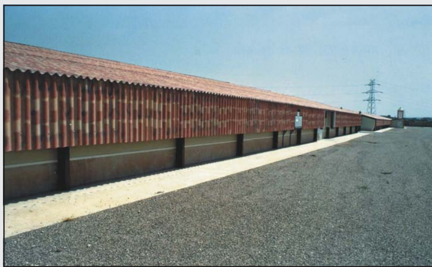
Dos de las grandes naves de crianza de codornices para carne, de 100 x 14 m.
