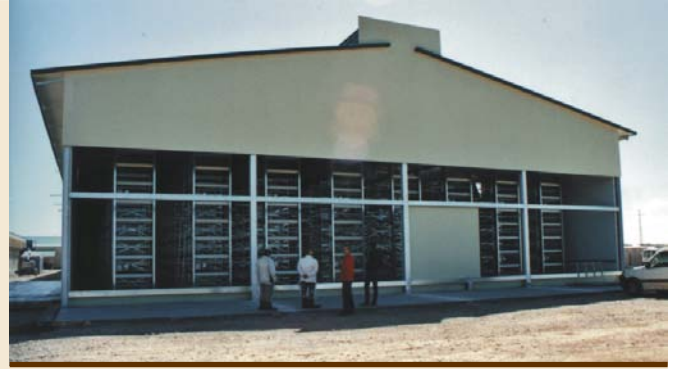
La segunda nave de puesta, en proceso de equipamiento.
