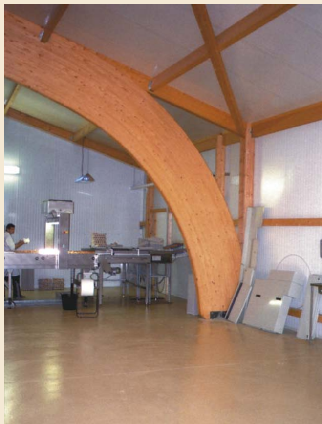
El pie de uno de los pórticos de madera, en un extremo del centro.
