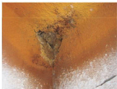
Daños en aislamientos y estructuras ocasionados por A.diaperinus .
