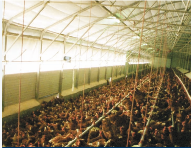
Otra vista interior de la misma nave, con mayor detalle de su estructura y la fachada.
