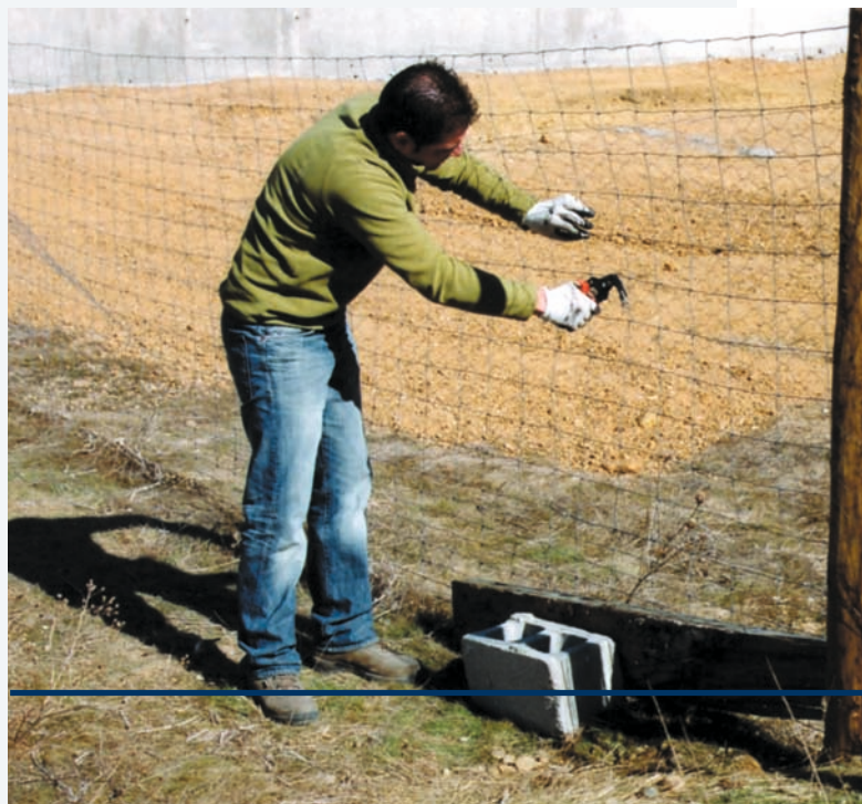
Reparando la valla del parque para evitar que las aves se acerquen a la zona en obras.
