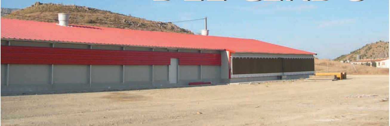
Vista parcial de una fachada de la nave, observándose los "coolings" para la refrigeración en modo túnel.
