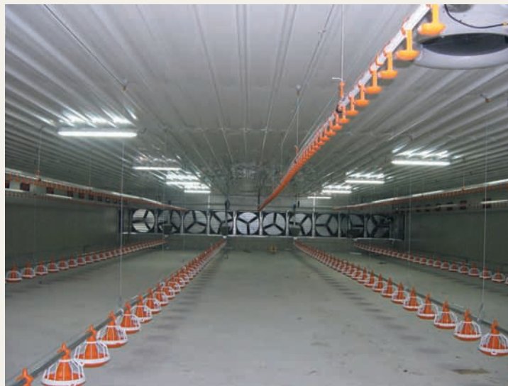
Aspecto del interior de la nave a punto de estrenarse, con los grandes ventiladores para funcionar con pollos grandes y/o en verano.
