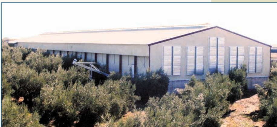
El extremo opuesto de la nave, en donde se hallan los extractores para la ventilación túnel.
