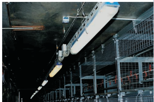
Diferencia evidente entre el color de la luz más cálida 830 (lámpara amarilla) y la luz de espectro total NARVA BIO vital 958.
