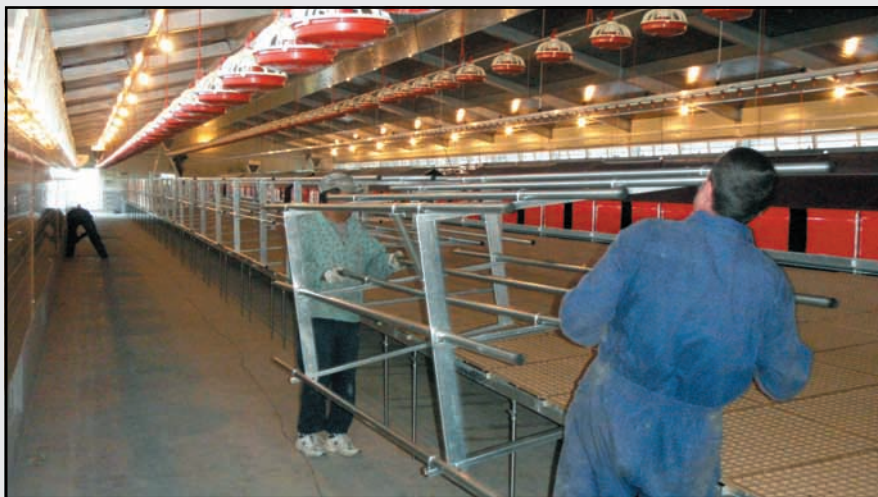
Montaje de aseladeros en una granja de gallinas ecológicas de reciente construcción. (Fotos E. Atxa)
