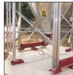
Silos con células de carga
