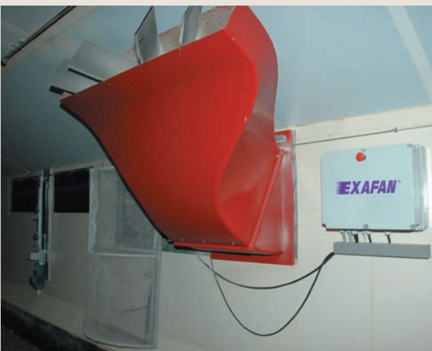
El deflector es regulable en altura y anchura y se adapta a diferentes pendientes de naves (0° hasta 45°).
