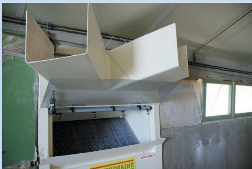
En la explotación de Claude Froger, cada nave Colorado de 1.250 m<sup>2</sup>, especializada para pavos, está equipada con dos intercambiadores ERC 500 de System, instalados sobre el muro lateral, por el lado de la entrada de aire.
