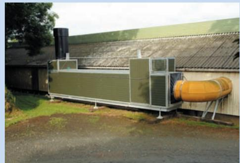
Jean Paul Madec ha equipado su instalación de pavipollos en doble arranque de 750 m<sup>2</sup> -ventilación estática- con un recuperador de calor Agro-Supply
