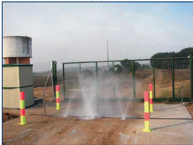
Sistema de desinfección en la entrada de vehículos de una granja. (Foto gentileza de AECA-WPSA)
