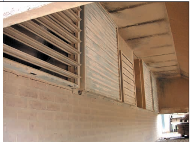
Fig. 6. Estructura para evitar la emisión de partículas de polvo al exterior, instalada en la salida de ventilación de una explotación de gallinas ponedoras en Holanda -izqda- y detalle del interior de la estructura y de la acumulación de polvo -dcha-. (Foto del autor, 2010)
