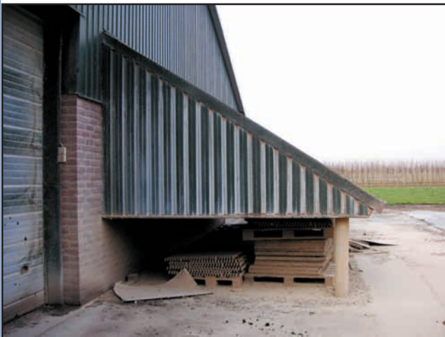
Fig. 6. Estructura para evitar la emisión de partículas de polvo al exterior, instalada en la salida de ventilación de una explotación de gallinas ponedoras en Holanda -izqda- y detalle del interior de la estructura y de la acumulación de polvo -dcha-. (Foto del autor, 2010)
