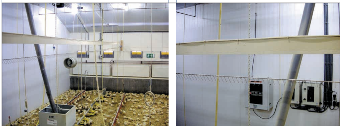
Fig. 5. Sala piloto de broilers con sistema de ionización del aire suspendido en el techo -izda.- y detalle del generador de iones y superficies de recogida cargadas de polvo -dcha-. (Cambra-López y col., 2009)
