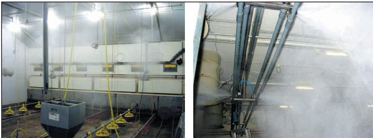
Fig. 4. Sala piloto de broilers con sistema de pulverización de aceite -izquierda- y momento de la pulverización y la formación de micropartículas -derecha-. (Winkel y col., 2009)
