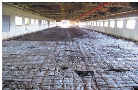
Piso con lámina de polietileno y mallazo electrosoldado antes de recibir el hormigón.
