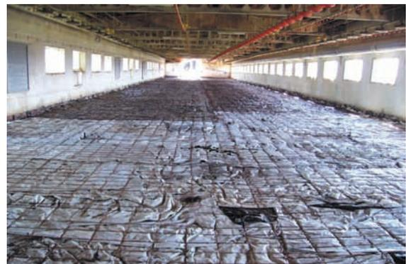
Piso con lámina de polietileno y mallazo electrosoldado antes de recibir el hormigón.
