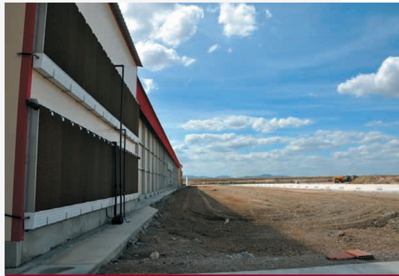
Uno de los laterales de la instalación, donde se puede apreciar el terreno en el que se construirán las dos próximas naves.
