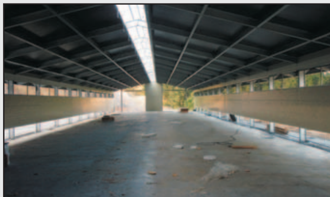
Detalle del hormigón raseado en la solera de la nave
