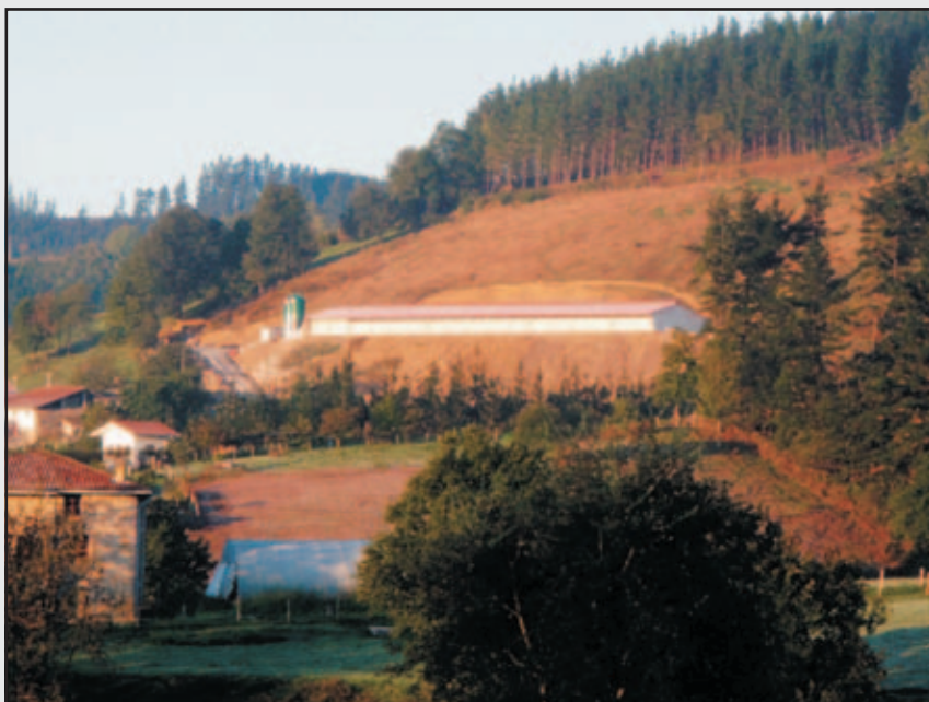
Vista de la nueva explotación. Se puede observar el trabajo de desmonte que ha habido que realizar en el terreno. Foto: Esteban Atxa Calvo
