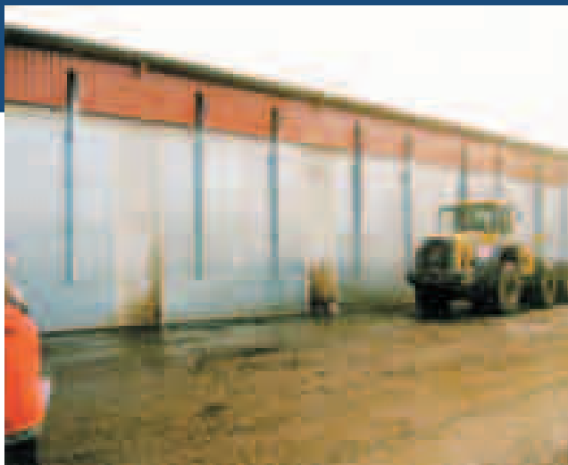
Aspecto de una instalación de metanización en fase seca: pueden verse las puertas estancas que cierran los compartimentos.
