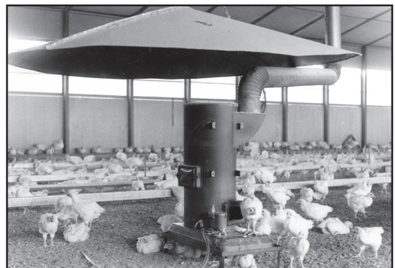
Una típica estufa de biomasa, con el montaje que solía hacerse en los años sesenta, cuando no se vigilaba tanto el gasto en calefacción.
