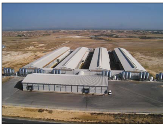
Vista general de una nueva instalación de Pascual de Aranda, con 4 naves provistas de jaulas enriquecidas, para 500.000 gallinas.
