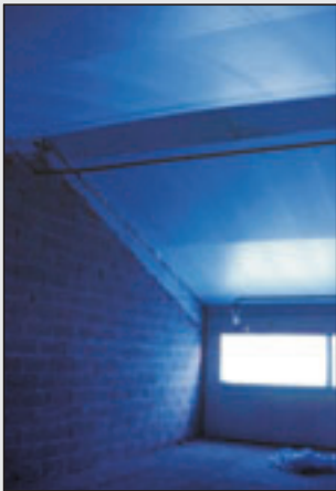
El aislamiento en techos y paredes es esencial para conseguir un ambiente adecuado para las aves, especialmente, y en el período de arranque. Las ventanas deben ajustarse a sus soportes para evitar fugas de calor y su apertura se graduará de acuerdo con las necesidades de las aves en esa fase. (Fotos Proavial)
