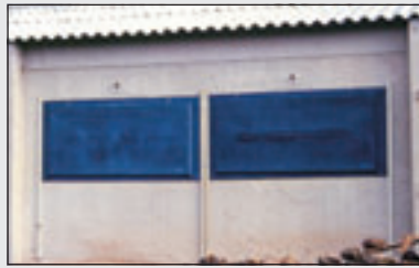
El aislamiento en techos y paredes es esencial para conseguir un ambiente adecuado para las aves, especialmente, y en el período de arranque. Las ventanas deben ajustarse a sus soportes para evitar fugas de calor y su apertura se graduará de acuerdo con las necesidades de las aves en esa fase. (Fotos Proavial)
